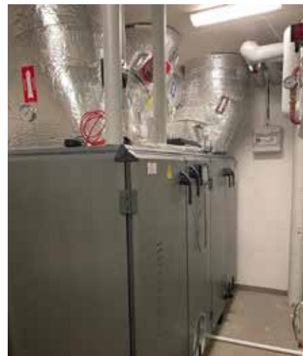
Nya ventilationsaggregat i Långekärrens skola.
