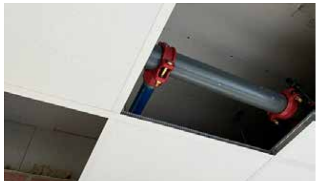
Installation av sprinklerledningar, Tubberödshus äldreboende.
