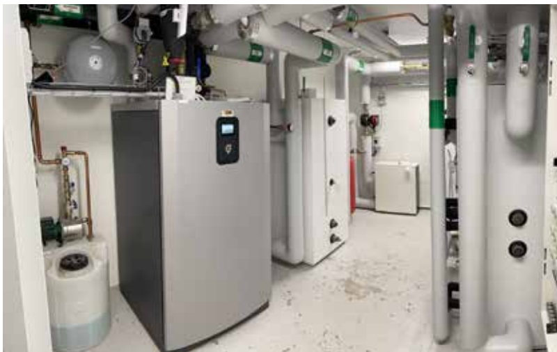
Bergvärme har installerats på Tubbegatan i Skärhamn.
